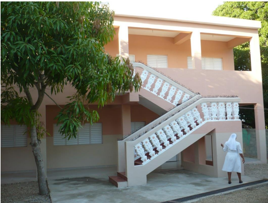
Nuevo edificio construido con la donación del Gobierno del Japón
